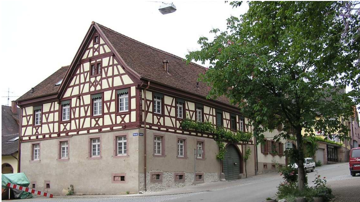
Abbildung 3: Erfolgreiche energetische Modernisierung in Eichstetten – 70 % besser als Neubaustandard, u.a. durch Innendämmung und einen Holzpelletkessel (Quelle: Deutsche Energie-Agentur)
