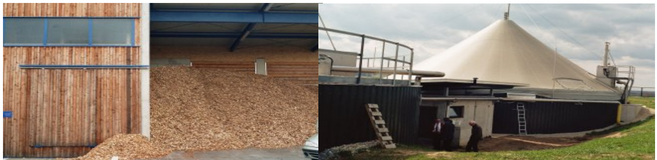
Nahwärmenetz Gemeinde Strem, bei Güssing, hier versorgt eine Holzhackschnitzel-Biogas-Kombination das Dorf. Nach ähnlichem Prinzip werden inzwischen alle 24 Gemeinden des Bezirks Güssing (entspricht einem Landkreis) mit Wärme versorgt.
