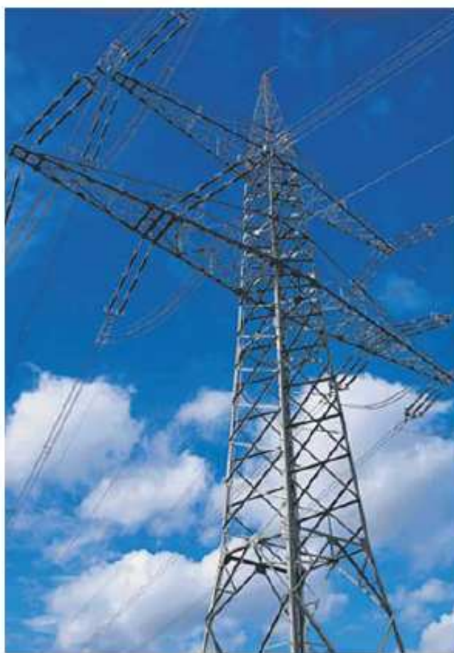
Die Sache mit dem Strom: ein Milliardengeschäft.
